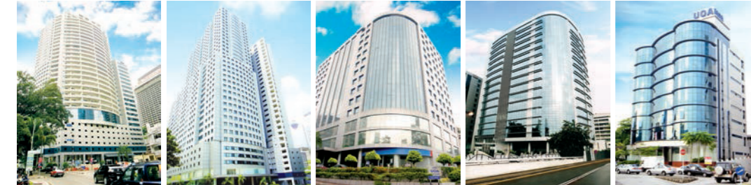
UOA Centre Jalan Pinang, KL Wisma UOA II Jalan Pinang, KL Wisma UOA Damansara Damansara Heights, KL Wisma UOA Damansara II Damansara Heights, KL Wisma UOA Bangsar Bangsar, KL
